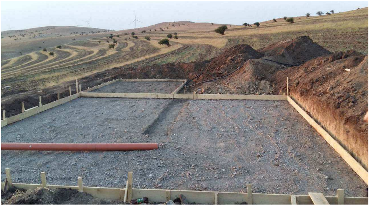
Fundatie bazin inmagazinare apa
