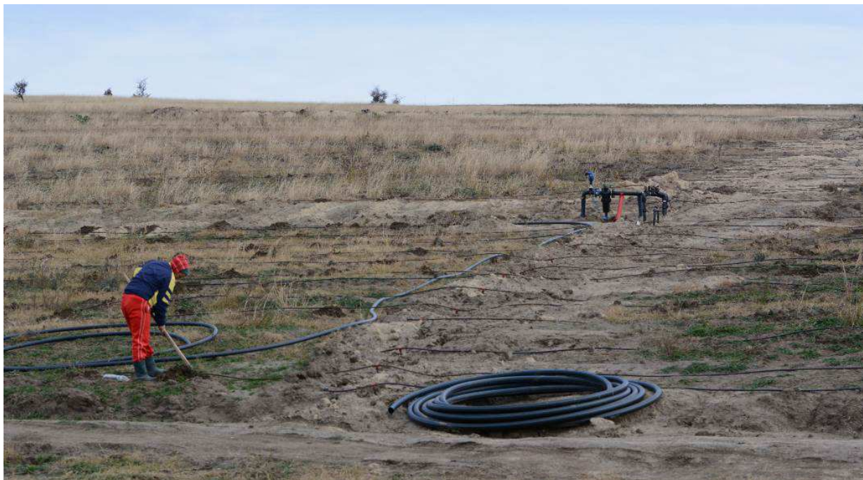
Amplasare sistem de irigatii (2015)
