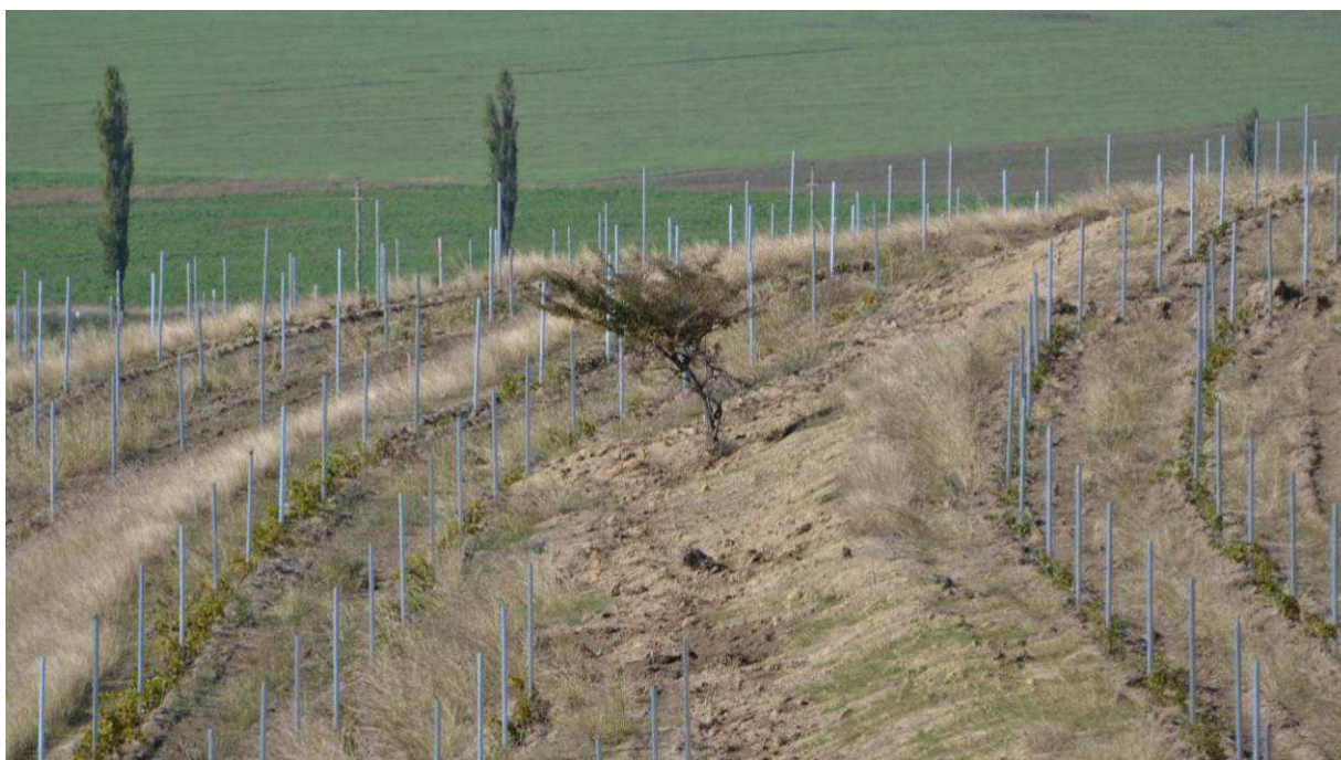
Aspect de ansamblu al sistemului de sustinere
