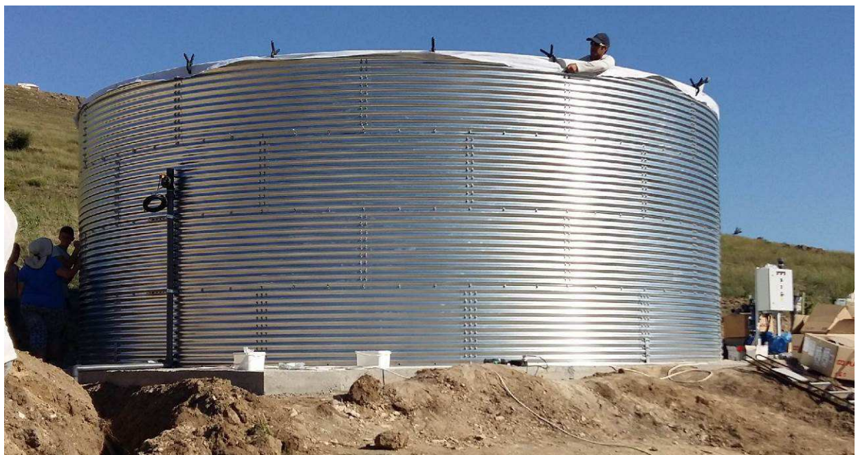
Construire bazin inmagazinare apa
