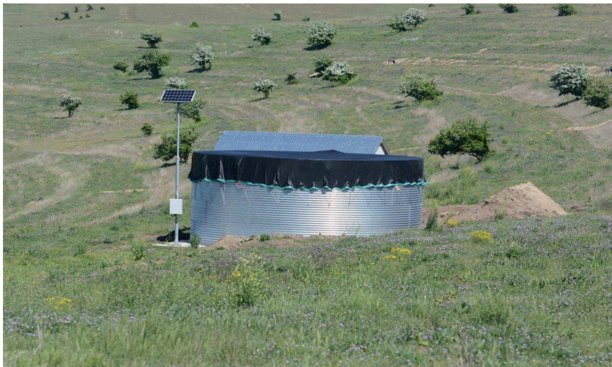
Aspect al sistemului fotovoltaic alaturat bazinului de inmagazinare
