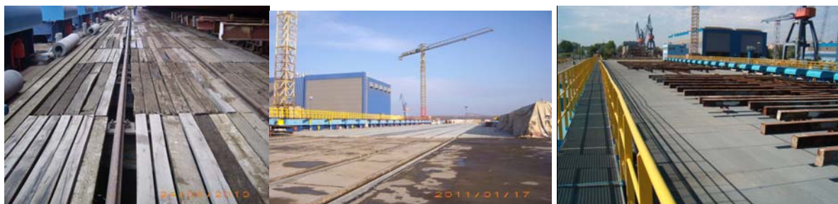
Figura nr. 16. Syncrolift – Inlocuirea platformei din lemn cu gratare metalice tip „Offshore”
