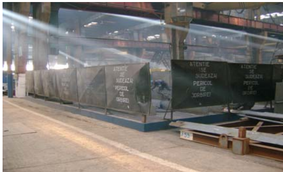
Figura nr. 73. Amenajarea imprejmuire zona sudura
