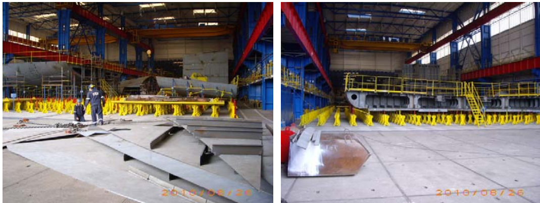
Figura nr. 14. Hala Prefabricare – Inlocuirea patului de asamblare cu sistem asamblare tip Pin-Jig
