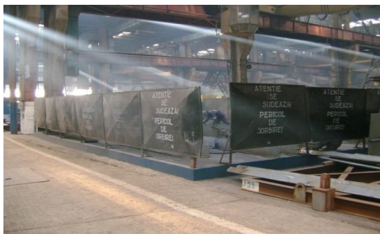
Figura nr. 50. Amenajarea imprejmuire zona sudura
