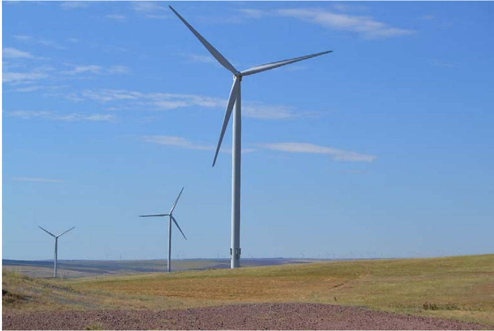
Aspect general al amplasamentului
