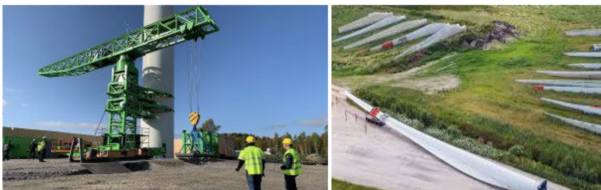
Imagini de la realizarea unui parc eolian cu turbine
