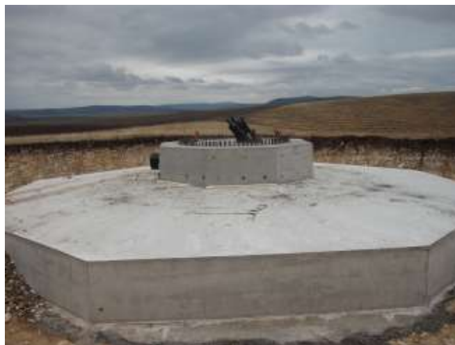
Fig .8 - fundatie turbina eoliana- foto original Badea Gh.
