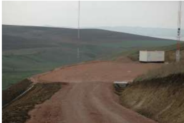
Fig. 7- platforme de lucru -foto original Badea Gh.
