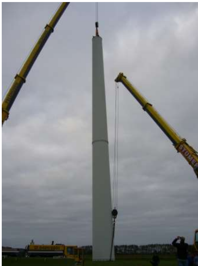
Fig. 10-montarea turnului unei turbine de mari dimensiuni ( sursa www.windpower.org )
