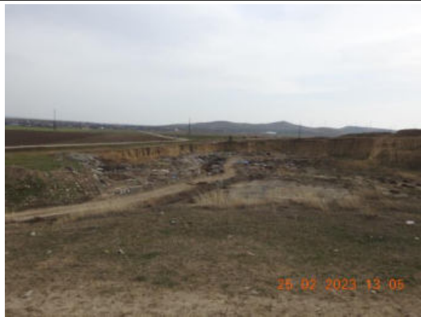
Foto 11: Groapa de gunoi neconformă, vedere dispres turbina 3
