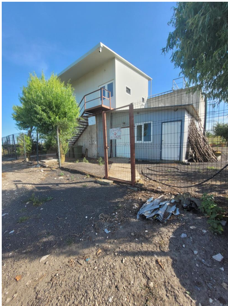
Zona stație de epurare
