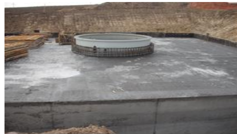
Fig .1- fundatie turbine eoliانا- foto original Badea Gh.
