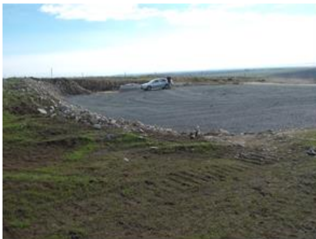
Fig.2- platforme de lucru -foto original Badea Gh.
