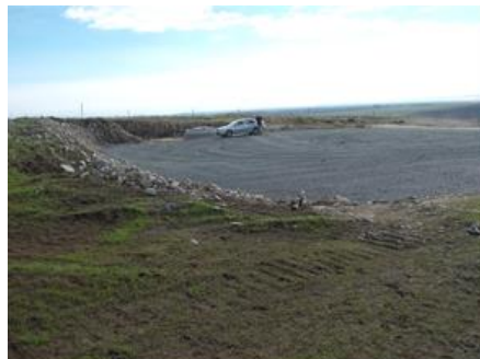
Fig.2- platforme de lucru -foto original Badea Gh.
