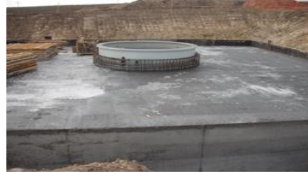
Fig .1- fundatie turbine eoliana- foto original Badea Gh.
