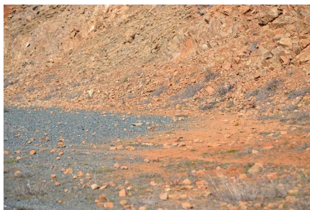
Fig. 7 - pietre dislocate de pe taluze datorita animalelor
