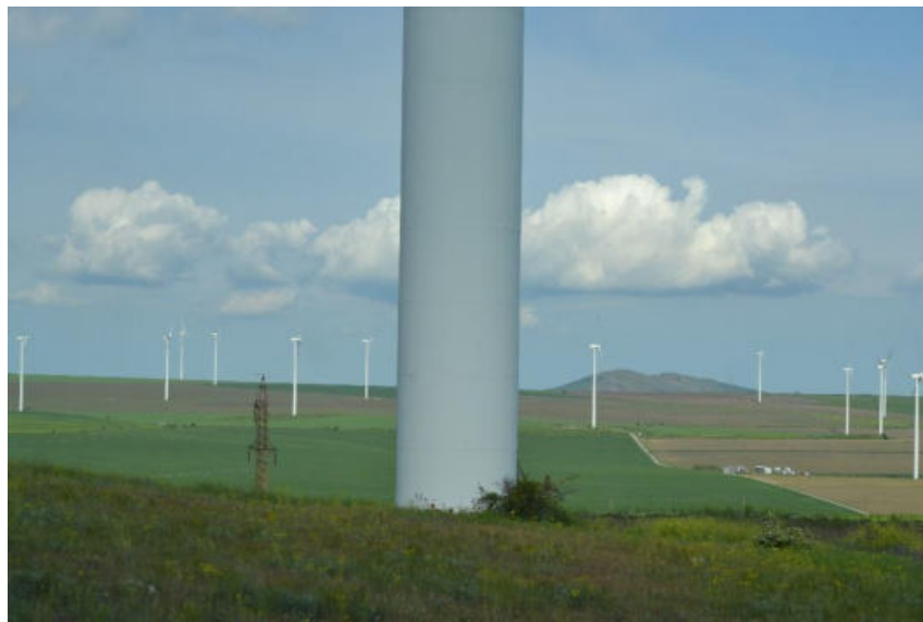
Fig. 6 - Taluz platforma turbina innierbata
