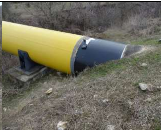
Figura nr. 33 Amplasament supratraversare existentă în punctul de intervenție TA7 reizolare intrare/ieșire
