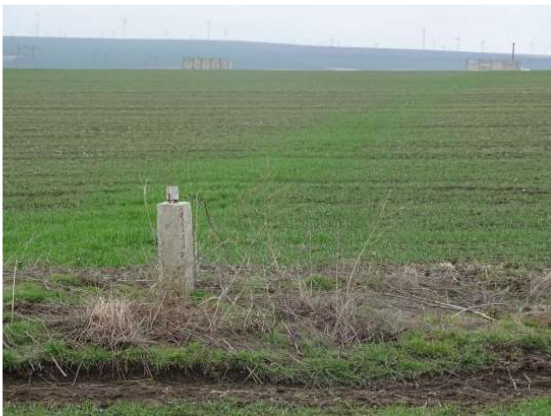
Figura nr. 6 Amplasament conducta existentă punct de intervenție reparația conductei REP 2, Baia
