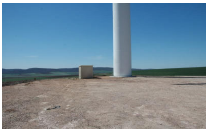
Fig.5- platforme de lucru -foto original Badea Gh.
