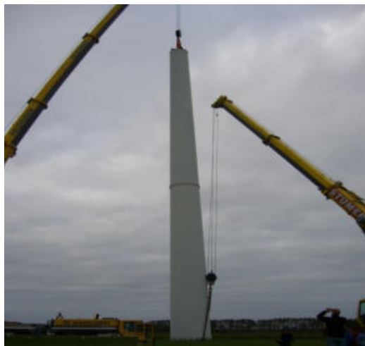
Fig. 8 -montarea turnului unei turbine de mari dimensiuni ( sursa www.windpower.org )
