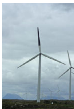
Fig.50- pala turbina eoliانا (2/3 din lungime ) vopsita in negru
