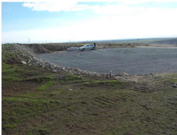
Fig.7- platforme de lucru -foto original Badea Gh.
