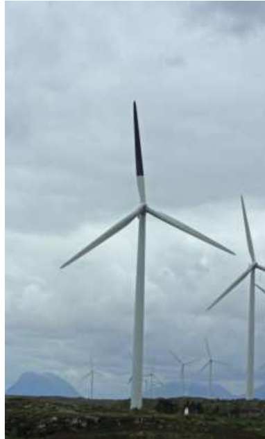
Fig. 46 - pala turbina eoliana (2/3 din lungime ) vopsita in negru
