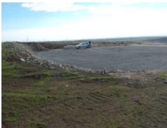
Fig.8- platforme de lucru -foto original Badea Gh.
