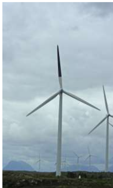
Fig.51- pala turbina eoliana (2/3 din lungime ) vopsita in negru
