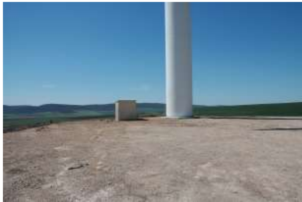
Fig.10- platforme de lucru -foto original Badea Gh.
