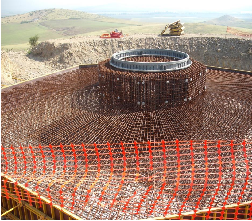
Fig .8 - fundatie turbine eoliana- foto original Badea Gh.
