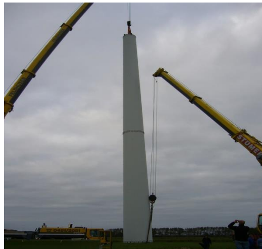
Fig. 10-montarea turnului unei turbine de mari dimensiuni ( sursa www.windpower.org )
