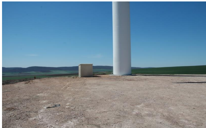
Fig.7- platforme de lucru -foto original Badea Gh.
