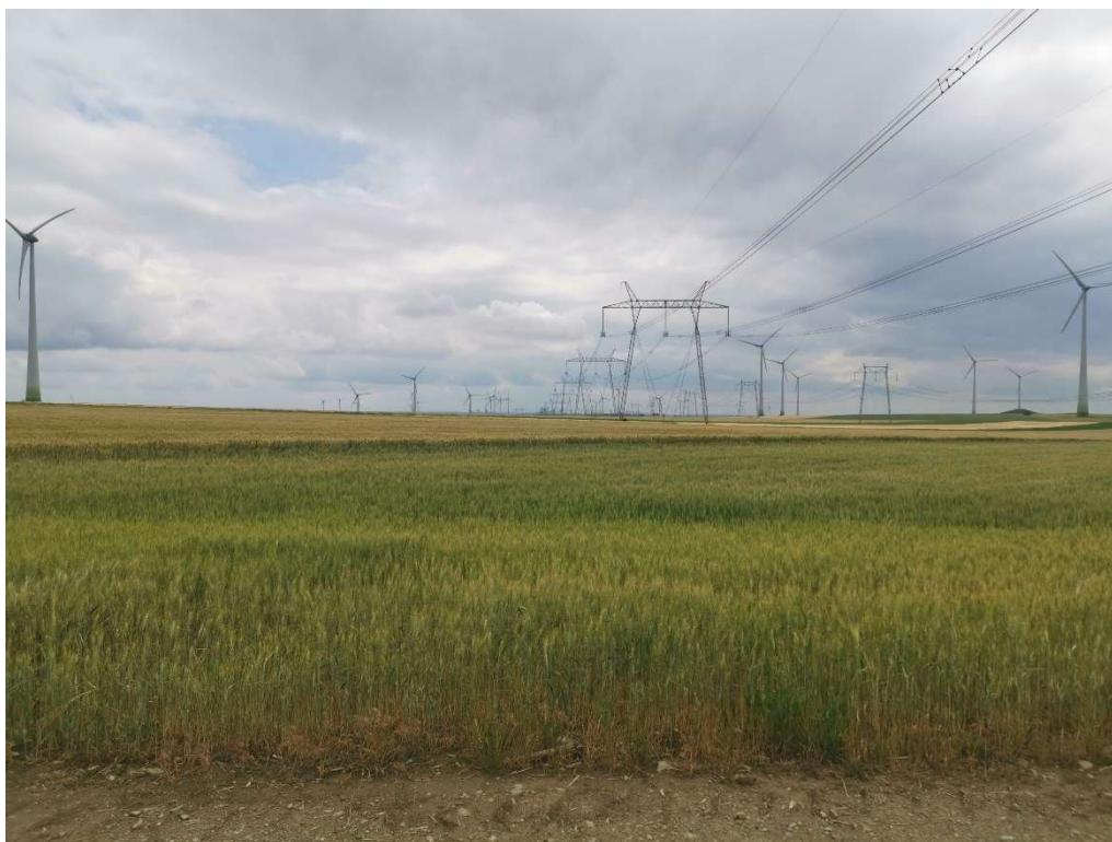
Foto 2-4: Vedere de pe drumul de exploatare propus a fi modernizat spre zona învecinată (vedere dinspre nord spre sud)
