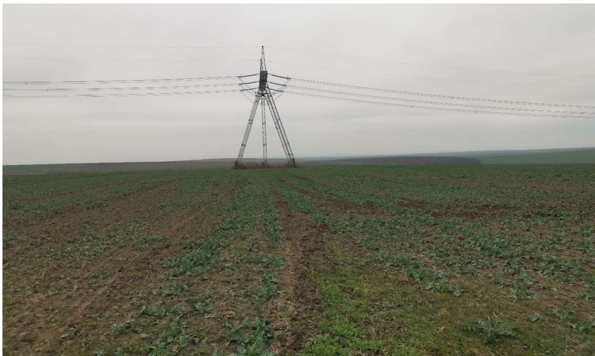
Foto 3-1: Aspect de pe amplasamentul P.U.Z. propus, zona propusă pentru Stația electrică
