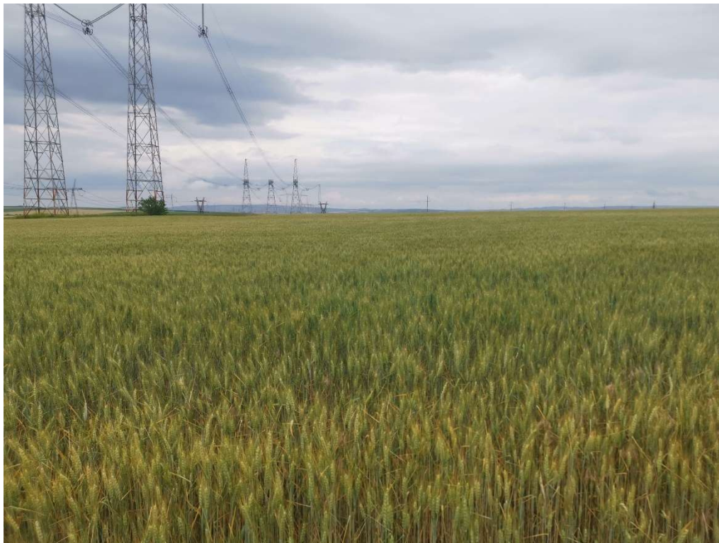
Foto 2-1: Vedere de pe drumul de exploatare propus a fi modernizat spre zona în care propusă amplasarea Stației electrice (vedere dinspre sud spre nord), în stânga linia LEA Transelectrica 750 kV Isaccea - Varna
