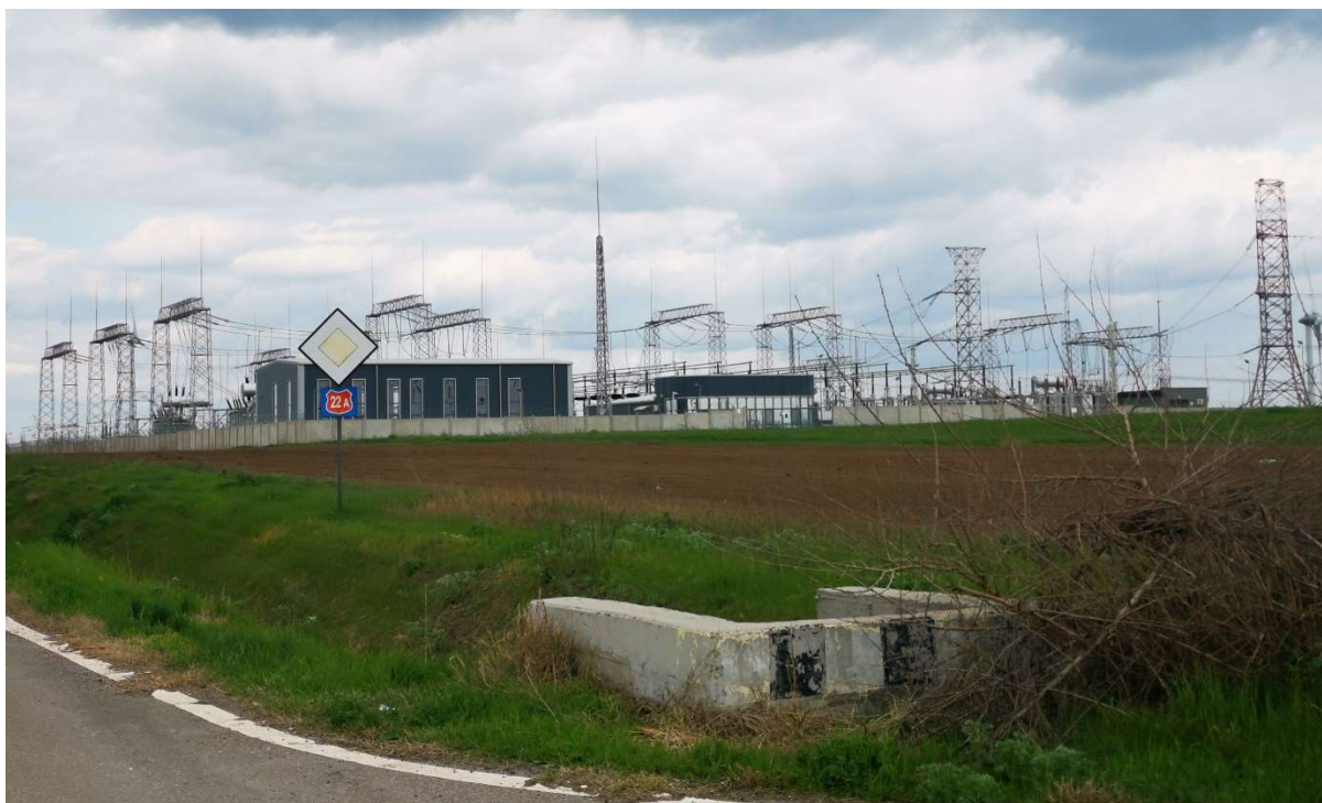
Foto 3-18: CN Transelectrica - 400/110 kV Rahman
