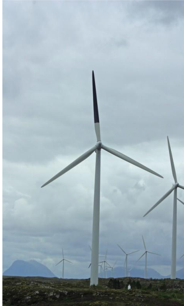
Fig. 29 - pala turbina eoliana (2/3 din lungime ) vopsita in negru
