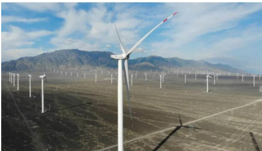
Eoliene cu ax orizontal cu rotorul de tip elice- Parc eolian cu turbine Goldwind
