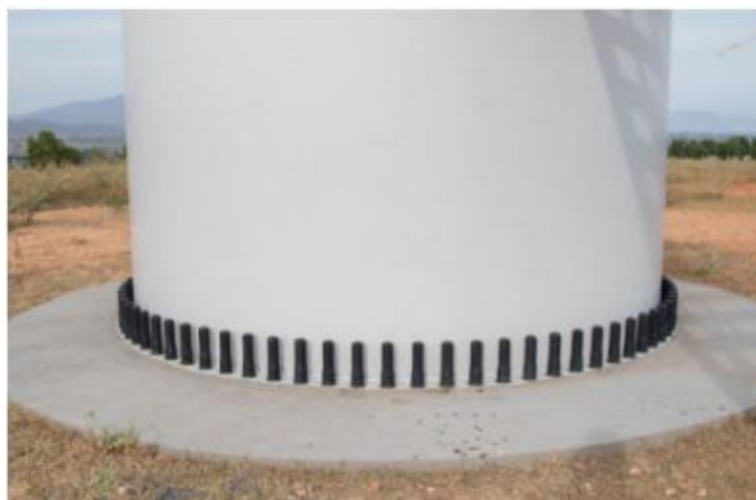
Exemplu de fundatie tipica si baza turn
