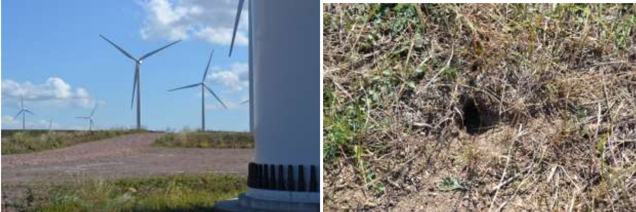
Fig. 37-38 Platforma turbina eoliana ( parc eolian in functiune din 2013 , care a fost construit pe terenuri arabile ) pe amplasamentul careia s-au identificat galerii ale speciei Spermophilus citellus
