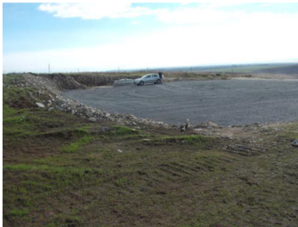
Fig.8- platforme de lucru -foto original Badea Gh.
