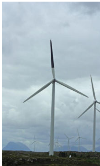
Fig.67- pala turbina eoliana (2/3 din lungime ) vopsita in negru
