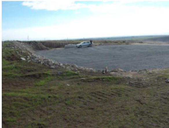
Fig.8- platforme de lucru -foto original Badea Gh.
