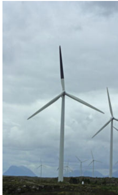
Fig.76- pala turbina eoliana (2/3 din lungime ) vopsita in negru
