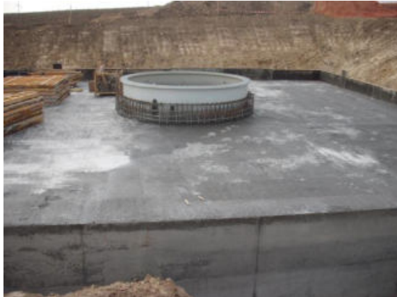
Fig .9- fundatie turbine eoliana- foto original Badea Gh. .
