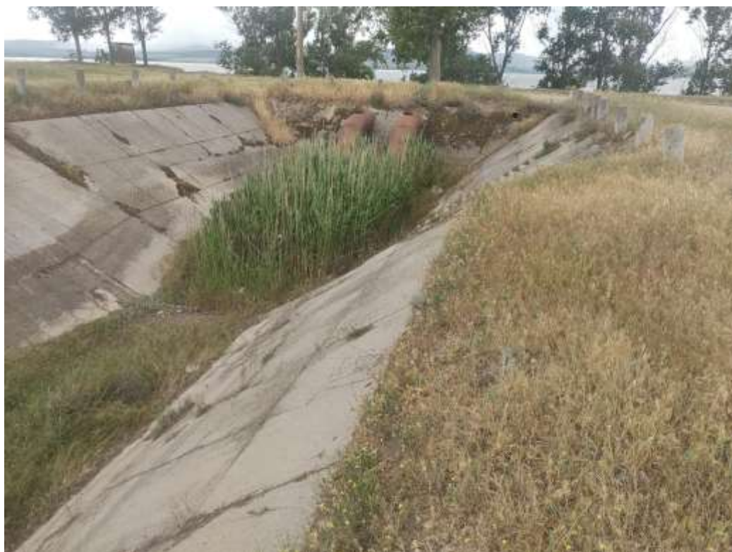
Bazin de refulare existent – de reabilitat
