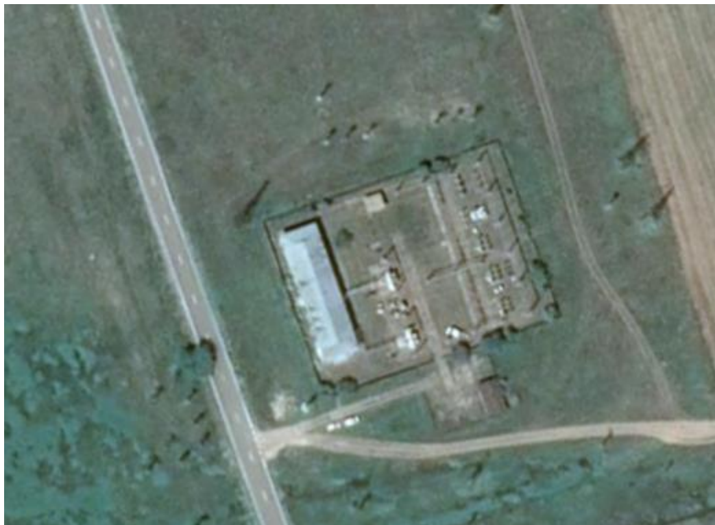
Modernizarea statiilor electrice de transformare din jud. Tulcea - Statiile 110/20kV Babadag, Isaccea, Sarinasuf si Zebil
